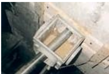
Perforazione carotata della muratura e particolare dell'inserimento della catena nel foro, vicino al quale è stata posta una vaschetta per il recupero dell'acqua usata durante la lavorazione.
