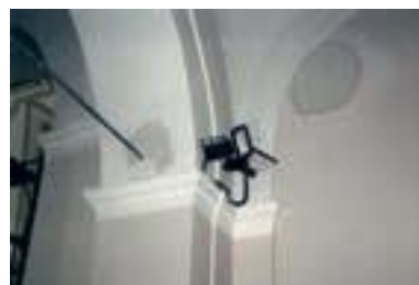
Sopra: l'inserimento delle catene con la posa in opera delle piattine in corrispondenza di entrambi i lati delle colonne di ciascun arco.
