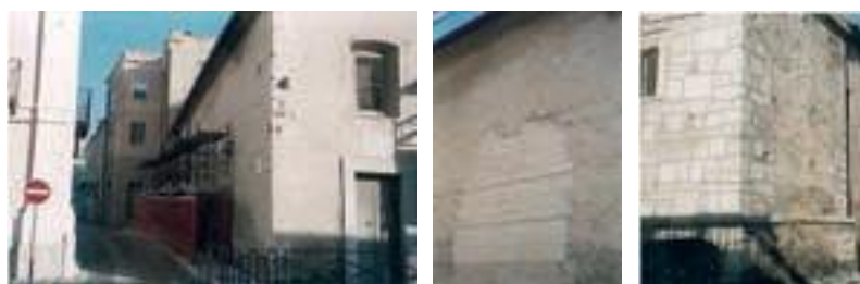
Immagini dei lavori eseguiti all'esterno.
